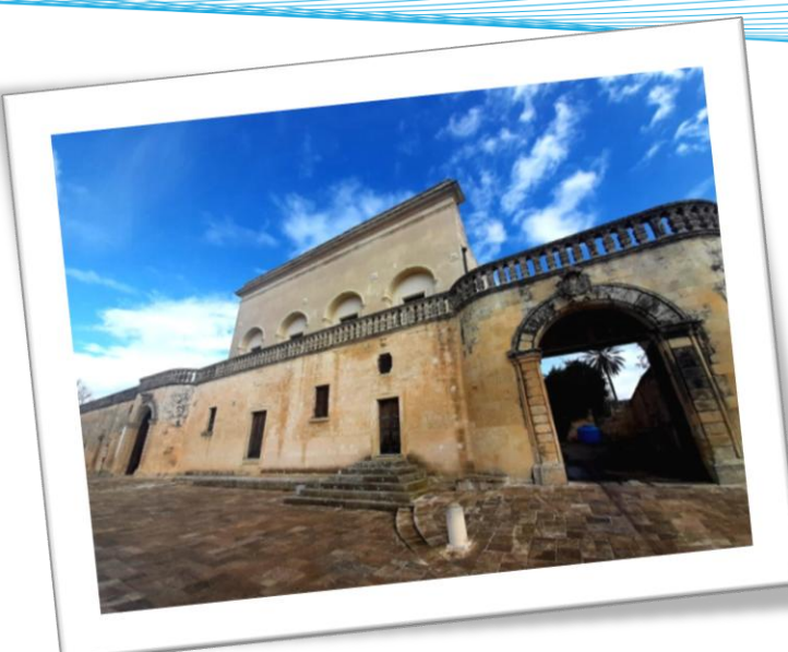
Fig.1. Prospetto frontale del Palazzo Marchesale di Botrugno (Lecce).
